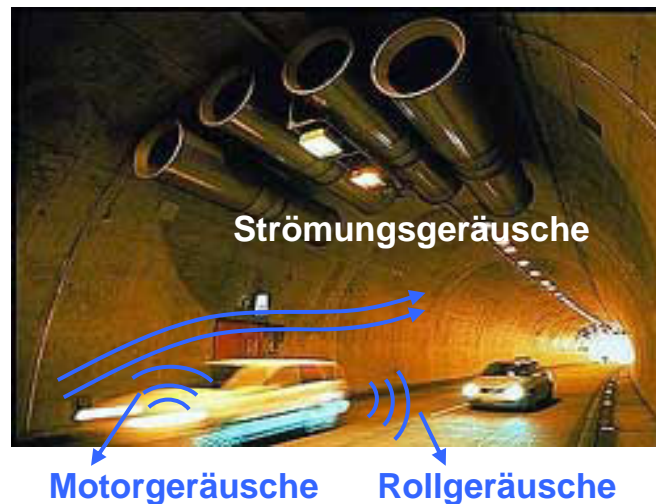
Abbildung 2 „Normale“ Betriebsgeräusche in einem Tunnel werden durch die Geräusche der fahrenden Kraftfahrzeuge geprägt
