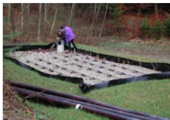
Abb. 34 : Vererdungsanlage Langegg (Klärschlammvererdungsbecken und Pflanzenkläranlage)
