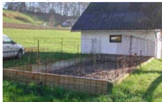
Abb. 20: Vererdungsbecken Dornegg (150 EW) Bau der Anlage und fertiggestellte Anlage im Frühjahr 2000
