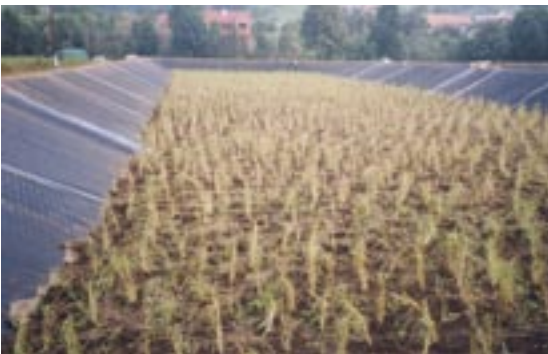
Abb. 35: Anlage Wies – Bau der Anlage (unten) und Anlage nach einem Jahr Betriebszeit (oben)
