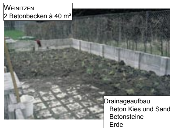
Abb. 17: Aufbau der Schlamm-trockenbecken in Weinitzen
