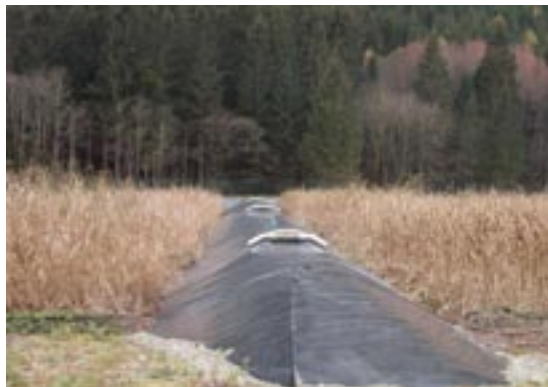
Abb. 36: Klärschlammvererdung des Reinhalteverbandes Mölltal – Anlage für 15 000 EW
