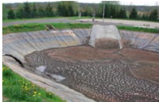
Abb. 32 : Anlage in Wolfsberg i. Schwarzautal, noch unbepflanzt
