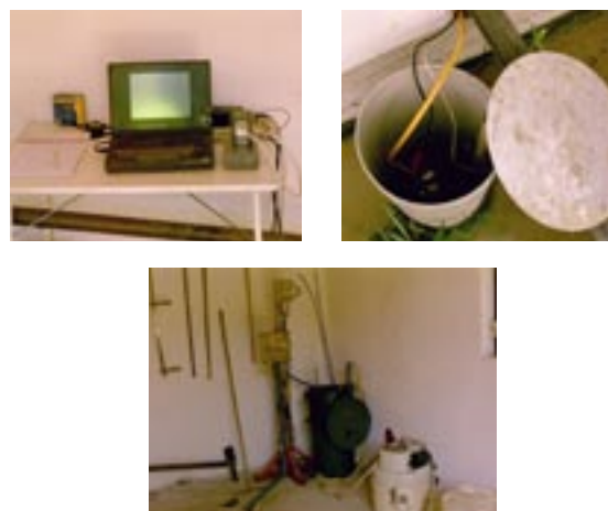
Abb. 26: Messeinrichtungen für quantitative und qualitative Sickerwasseranalyse in der Anlage Dornegg
