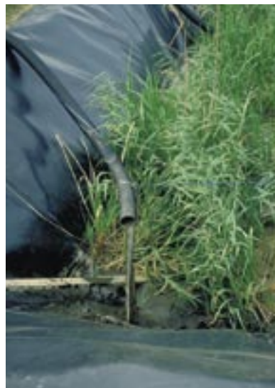
Abb. 11: Beschickung der Vererdungsbecken
