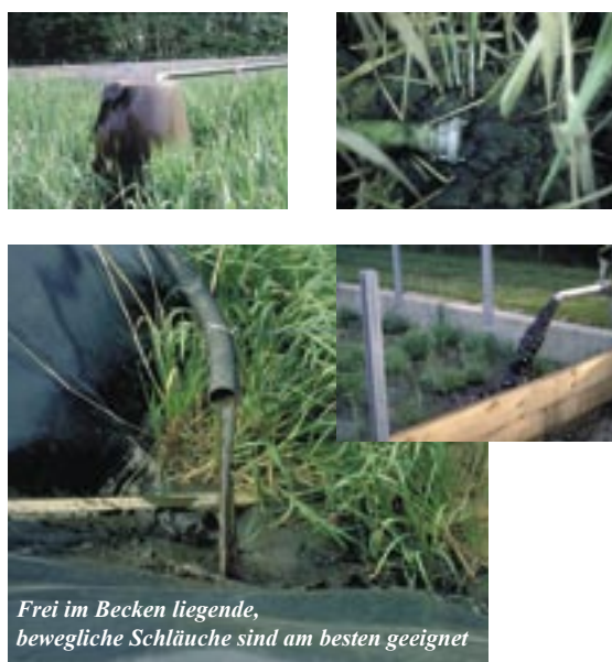
Abb. 21: Austestung verschiedener Beschickungsvorrichtungen
