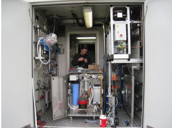
Abbildung 3-35 : Inbetriebnahme der Gesamtanlage durch Fa. Machintelligence
