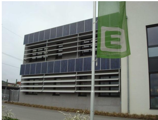
Abbildung 4-1 : PV-Anlage Pichler Werke, Werksweg Weiz
