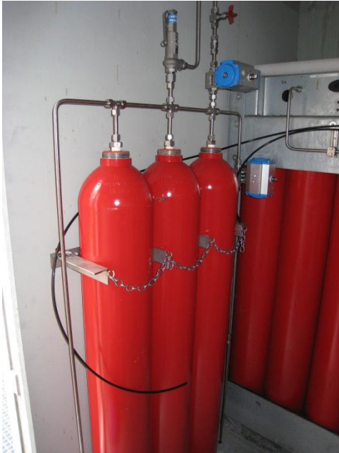
Abbildung 3-28: Wasserstoff-Zwischenspeicher
